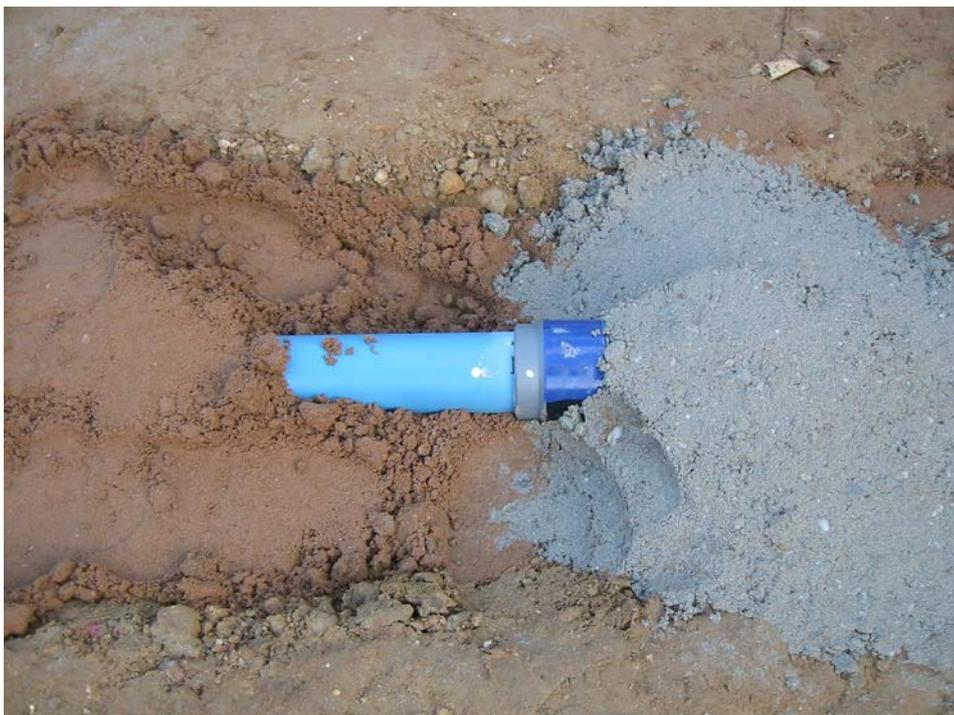
Foto 16: Magerbetoneinbau an der Muffe der Streckenmessrohre zur Erhöhung des Verbundes.
