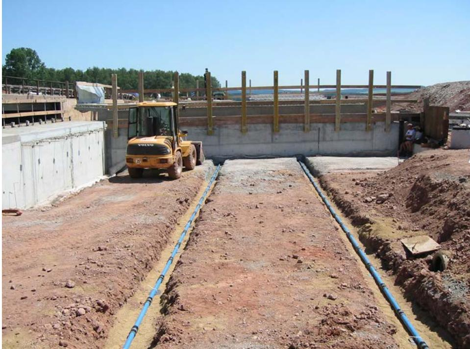
Foto 13: Einbau Streckenmessrohre L 11 und L 13 im Hinterfüllbereich 3, Blick zum Widerlager, deutlich sichtbar sind die Muffen der Messrohre im Abstand von 1,0 m.
