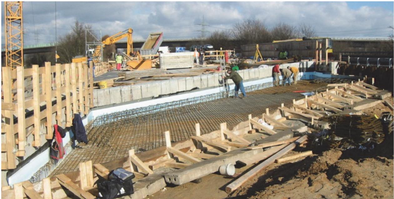
**Bild 8-5:** Bewehrungsarbeiten an der Schleppplatte im Hinterfüllbereich 2.
