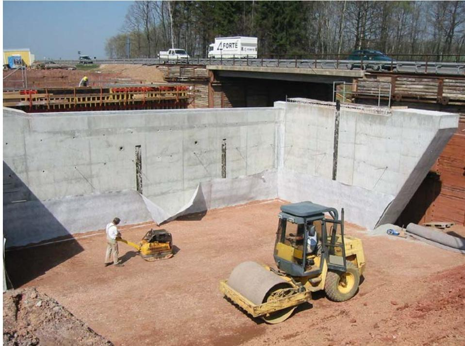
Foto 5: Verdichtungsarbeiten im Hinterfüllbereich 2 (Schotter 0/45) mit Walzenzug und schwerer Rüttelplatte am 18.05.2006.
