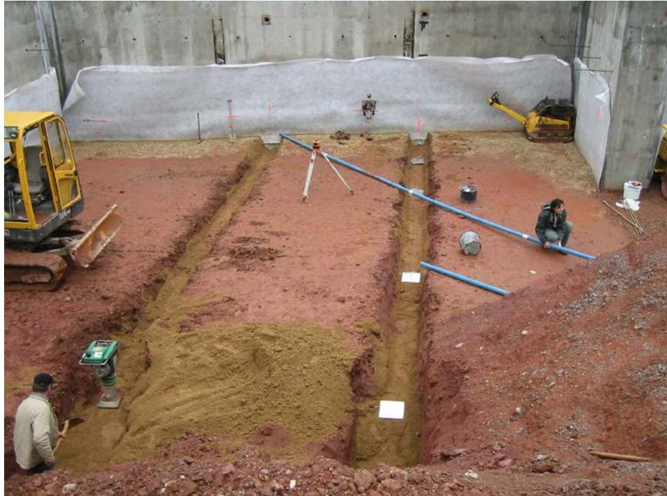
Foto 9: Einbau der Messrohre: Aushub von Gräben, Verdichtung der Sohle, Einbau eines Sandbettes, Verdichtung Sandbett, Einbau Messrohr, Überschütten zunächst mit Sand dann mit Hinterfüllmaterial, Verdichtung mit leichter Rüttelplatte.
