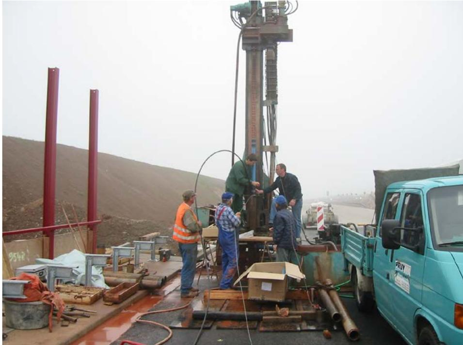
Foto 15: Einbau Vertikalmesststelle, Bohrungen von der fertig gestellten Richtungsfahr-
