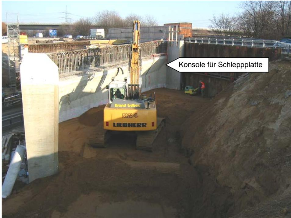
Foto 7: Hinterfüllarbeiten im Bereich 2 am 18.12.07, am Widerlager ist die Konsolle für die Schleppplatte erkennbar, Blick nach Nordosten.
