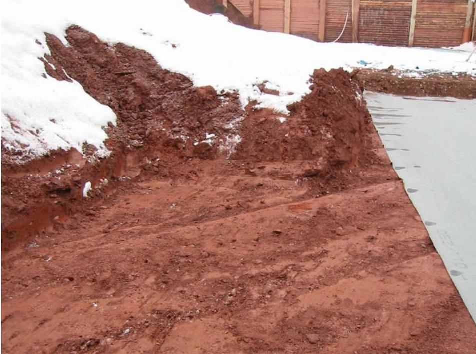
Foto 3: Abnahme der Gründungssohle Achse 20 am 15.03.2006, Wechsellagerung aus Sand mit wechselnden Kies- und Tonanteilen sowie stark sandigem Ton in halbfester Konsistenz.
