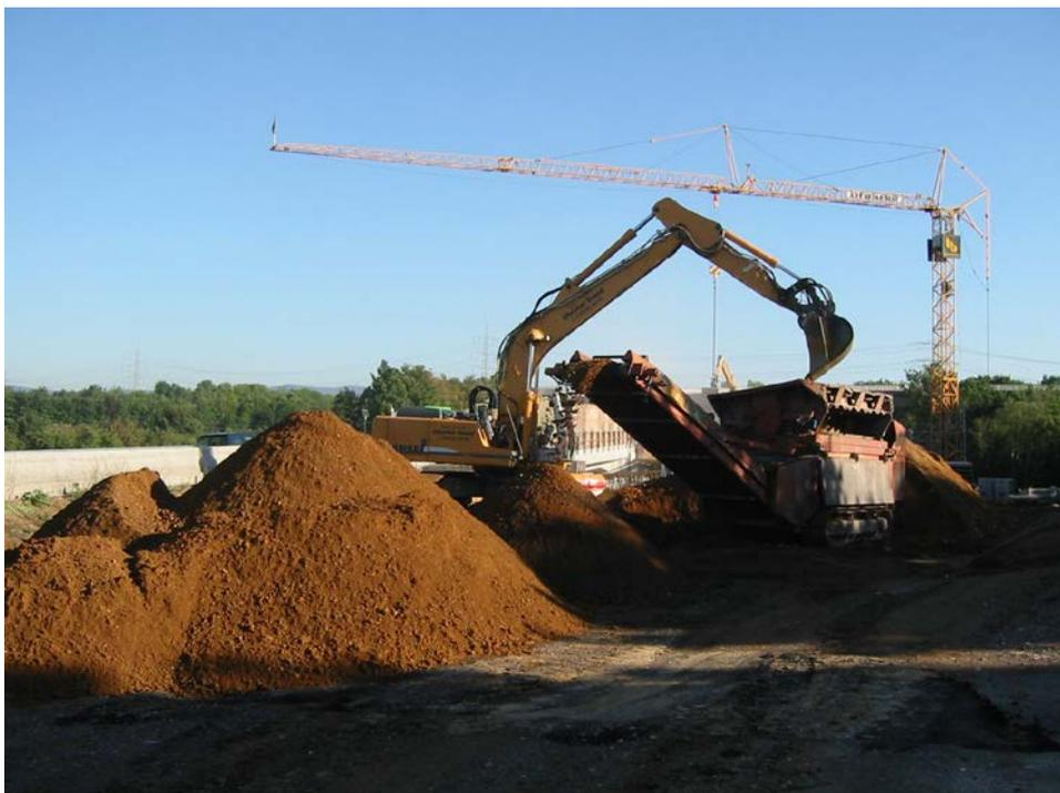
Foto 10: Vorbereitung des Ausgangsmaterials für die Herstellung der qualifizierten Bodenverbesserung im Hinterfüllbereich 4, Abtrennung des Überkorns mit einem Korndurchmesser größer 60 mm am 09.09.08.
