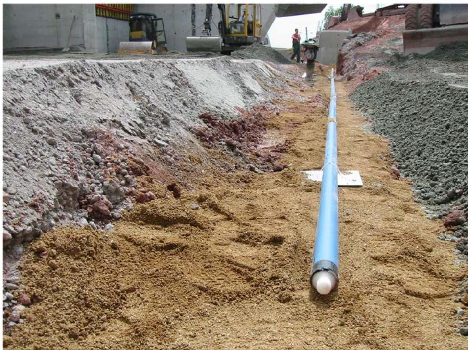
Foto 12: Verlegung Querinklinometer im Hinterfüllbereich 3 und 4, im Hintergrund ist die Einbindung in den Messschacht ersichtlich.
