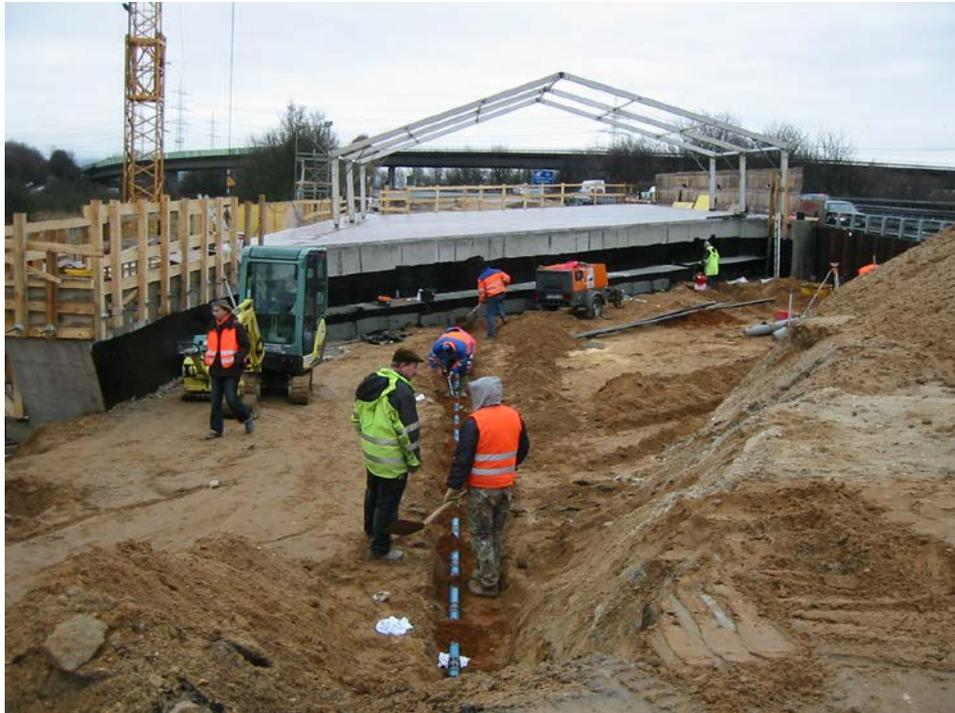
Foto 15: Einbau der obern Längsmessrohre S5 und S6 im Hinterfüllbereich 2 am 01.02.08.
