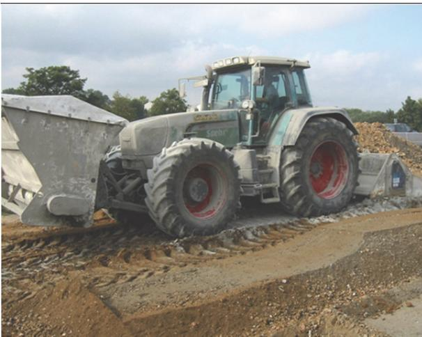
**Bild 8-6:** Einfräsen des Bindemittels.
