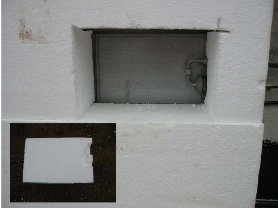
Foto 19: Druckkissen zwischen Widerlager und EPS-Hartschaumstoff im Hinterfüllbereich 3, Herstellung einer passgenauen Aussparung, 05.11.08.
