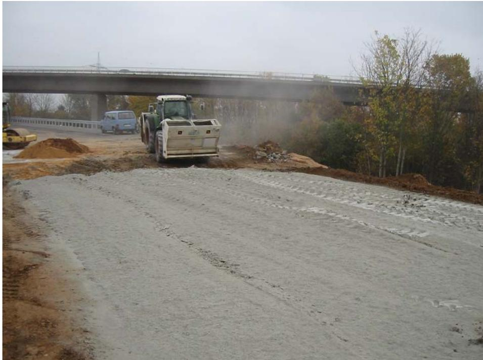
Foto 11: Mischfeld im an den Hinterfüllbereich 3 angrenzenden Streckenbereich nach dem Ausstreuen des Bindemittels am 06.11.08. Die Ausstreumenge wurde mit Prüfblechen kontrolliert.
