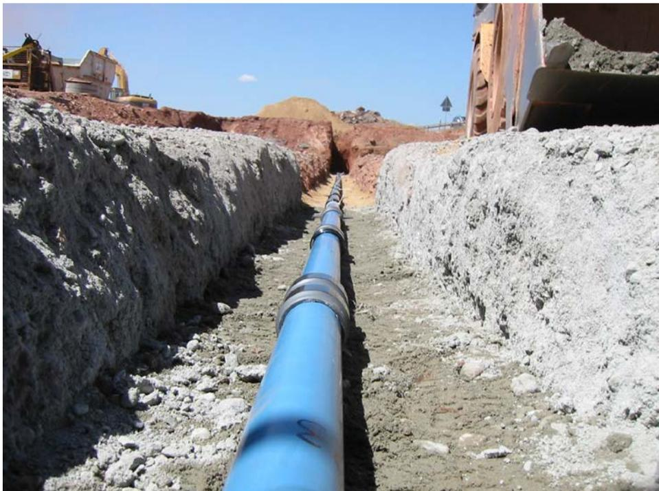
Foto 14: Einbau Streckenmessrohr, Blick zur Einbindung in den anstehenden Baugrund, genaue Rohrverlegung mit sehr geringen Höhendifferenzen.
