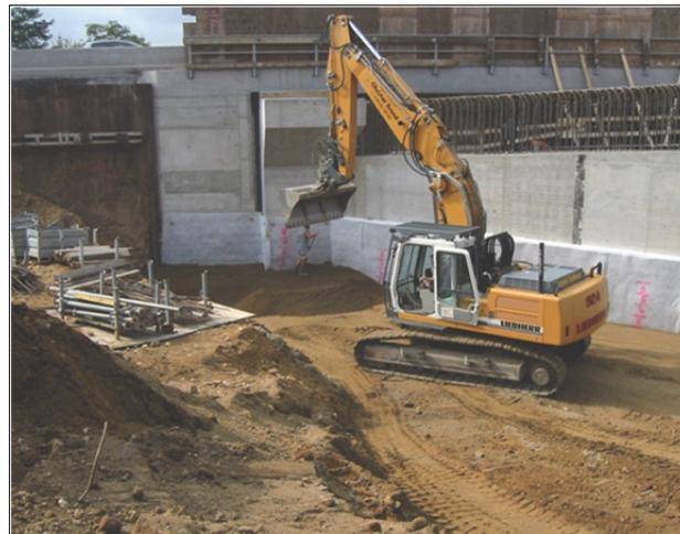
**Bild 8-7:** Einbau des Boden-Bindemittelgemisches.
