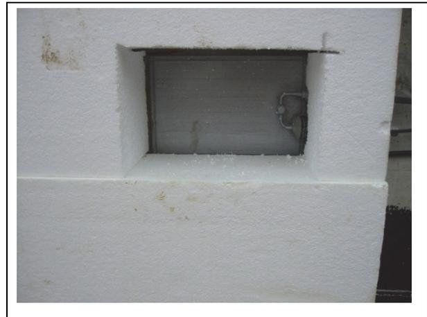
**Bild 9-2:** Einbau Erddruckgeber Hinterfüllbereich 3.
