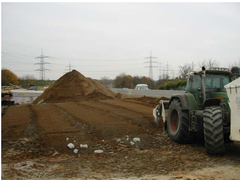
Foto 12: Einfräsen des ausgestreuten Bindemittels mit zwei Fräsdurchgängen zur Homogenisierung des Materials am 06.11.08.
