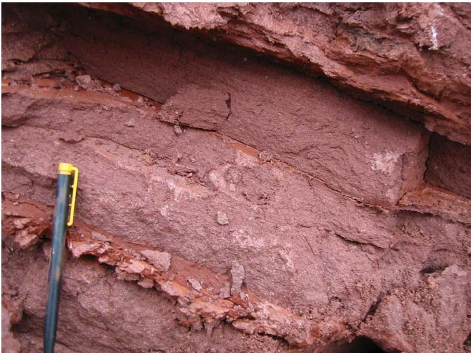
Foto 4: Detailaufnahme der Baugrubenböschung, deutlich zu erkennen ist der ursprüngliche Schichtverband mit dünnen Tonlagen zwischen ca. 10 cm dicken stärker sandigen Lagen.
