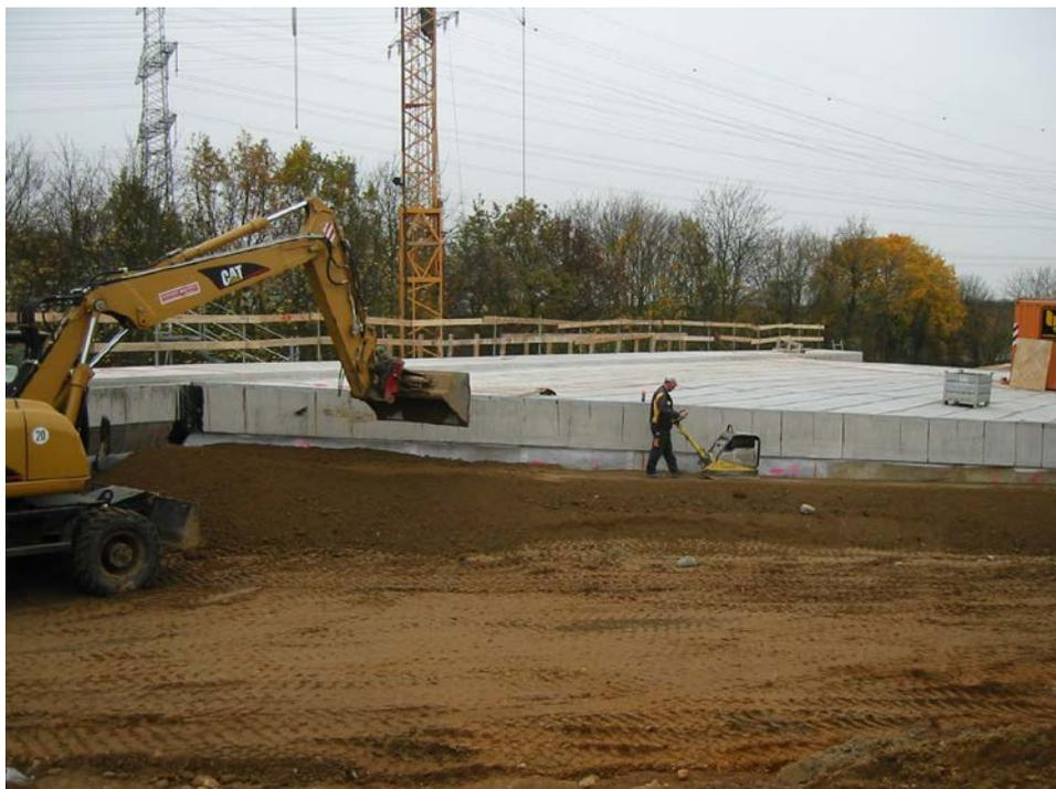
Foto 14: Einbau des Boden-Bindemittel-Gemisches im Hinterfüllbereich 3 am 05.11.08, im Vordergrund grobkörniger Boden oberhalb des Keils mit qualifizierter Bodenverbesserung.
