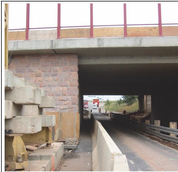
**Bild 6-1:** Verkehrssicherungsmaßnahme für Straßenbauarbeiten; Messrohre Widerlager Hof dadurch nicht zugänglich. Bei den unteren Messrohren kann das Gestänge nicht eingeführt werden. Für die Messung der oberen Messrohre kann das Fahrgerüst nicht aufgebaut werden..
