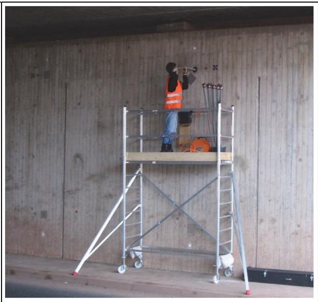
**Bild 6-2:** Messung der oberen Längsmessstellen am Widerlager Hof mit Fahrgerüst auf Fußweg nach Abschluss der Straßenbauarbeiten
