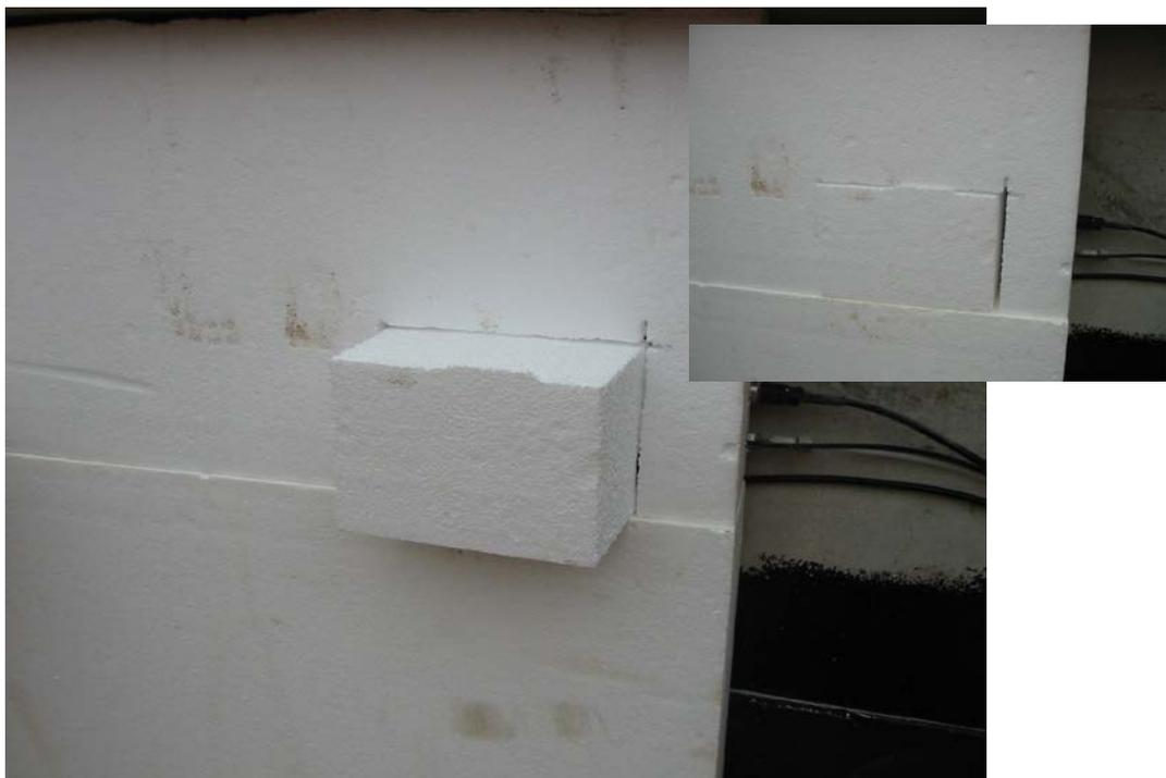
Foto 20: Einsetzen des ausgeschnittenen Blockes, abschließend wurde über dem EPS-Schaumstoff die Dränmatte verlegt und mit Boden-Bindemittelgemisch verfüllt.
