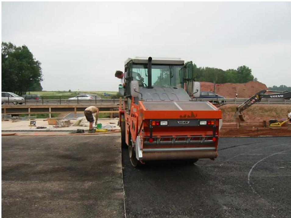
Foto 8: Verdichtung des Asphaltes direkt am Übergang zum Brückenbauwerk mit Tandemwalze.
