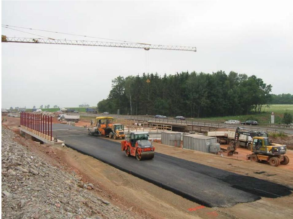
Foto 7: Einbau der Asphalttragschicht in der Richtungsfahrbahn Hof-Chemnitz am 12.07.2006, Blick nach Nordwesten.
