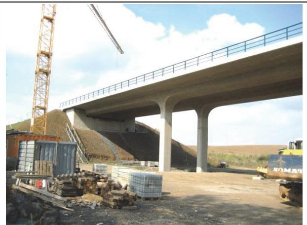
**Bild 2-10:** Semi-integrale Brücke, Pfeiler monolithisch mit Überbau verbunden, Lager und Fahrbahnübergänge an den Widerlagern (B 101 bei Freiberg).
