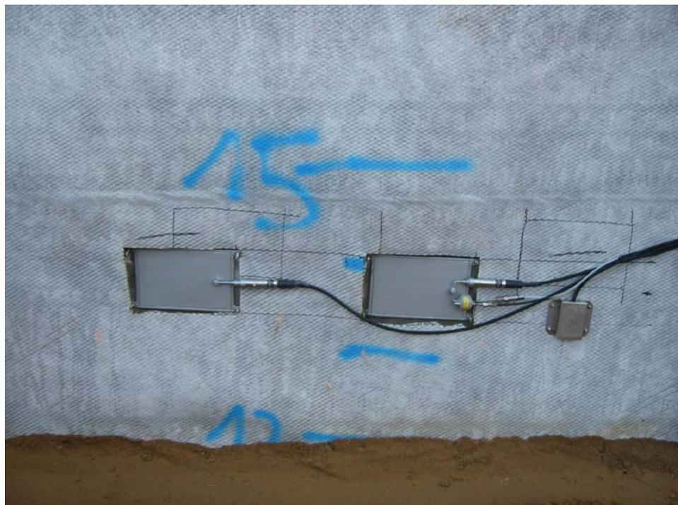
Foto 18: Einbau Druckkissen D03 und D04 am 06.02.08 im Hinterfüllbereich 1.
