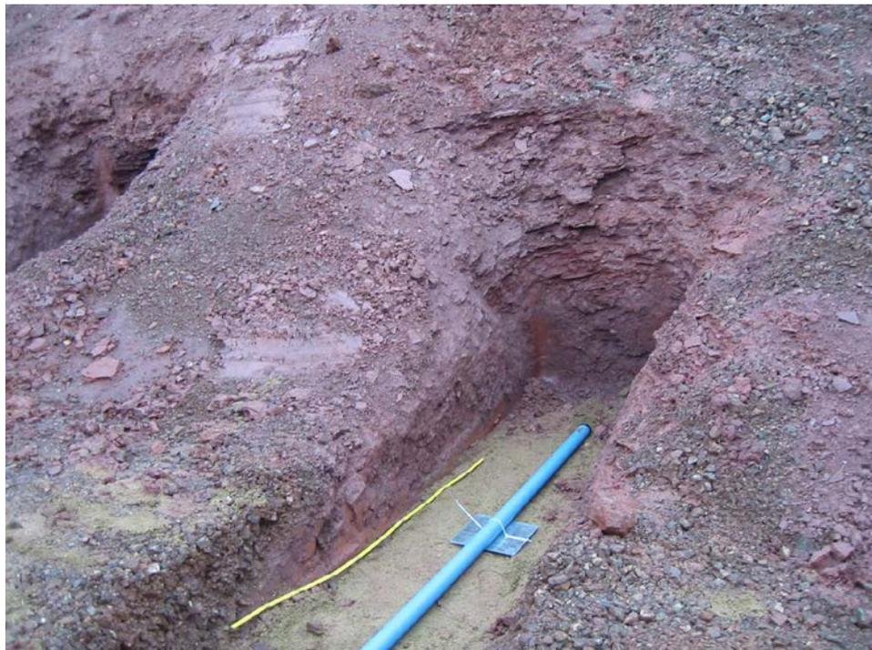
Foto 10: Einbindung der Längsklinometer in den anstehenden Baugrund (Mindestlänge 2,50 m)
