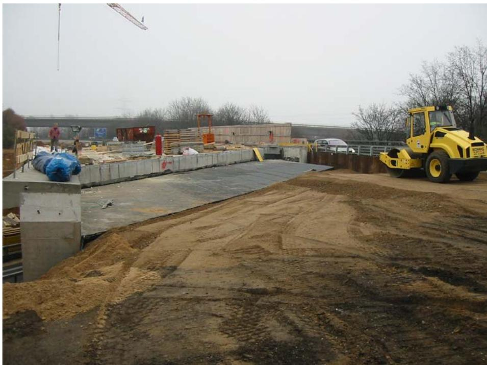
Foto 8: Hinterfüllbereich 2 mit fertig gestellter Schleppplatte am 14.02.08, Blick nach Nordosten.
