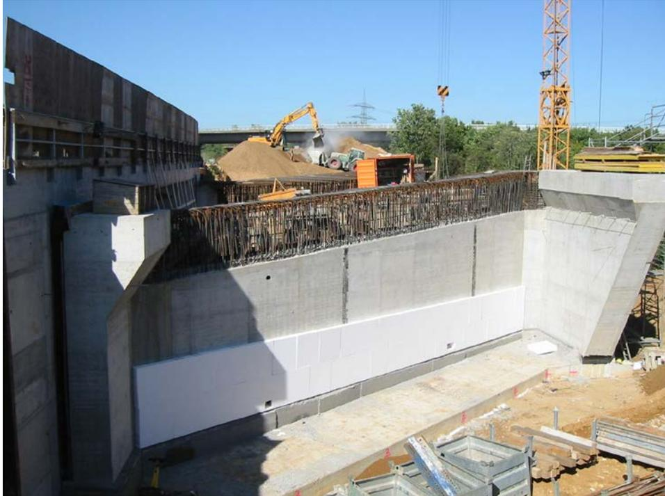
Foto 9: Einbau der vertikalen Schicht aus EPS-Hartschaumstoff an der Widerlager-rückseite im Hinterfüllbereich 4 am 09.09.08.
