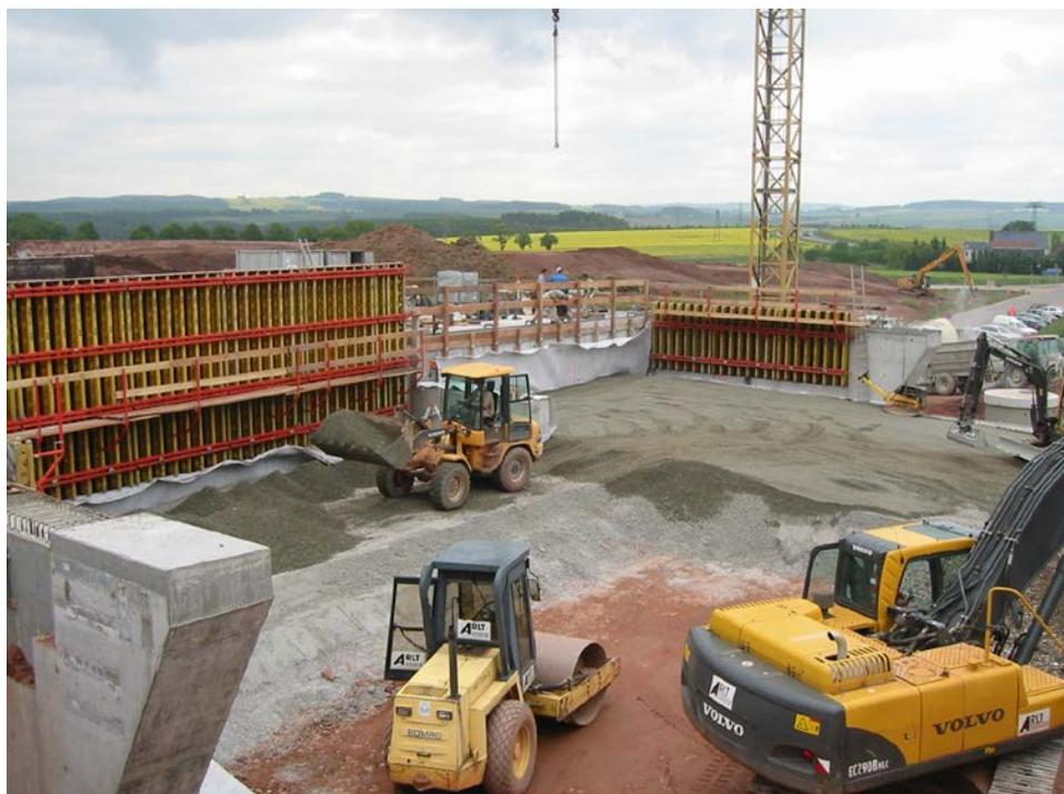
Foto 6: Einbau von Magerbeton in den Hinterfüllbereichen 3 und 4 am 06.06.2006, deutlich im Vordergrund erkennbar ist die stufenförmige Verzahnung des Magerbetonkeils, Blick nach Südosten.
