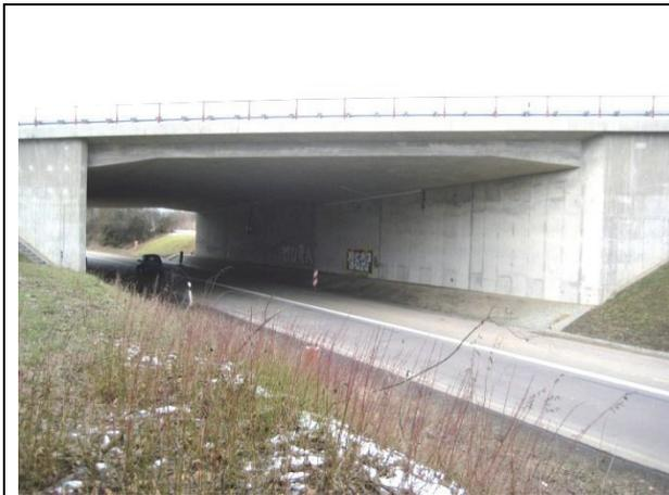
**Bild 2-9:** Integrale Brücke als Rahmenbauwerk ohne Lager (BAB A 66, Krielteler Dreieck).
