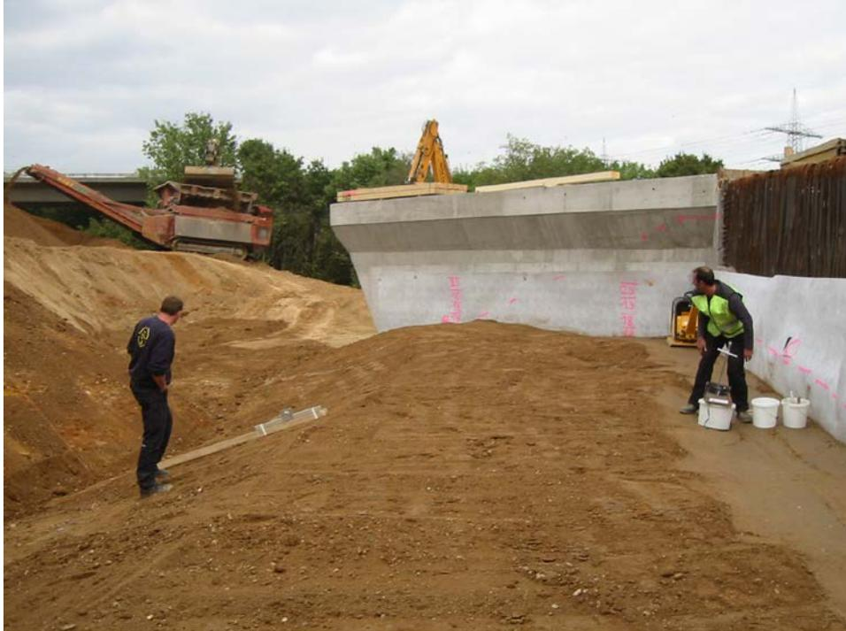
Foto 13: Einbau des Boden-Bindemittel-Gemisches direkt nach Abschluss der Fräsarbeiten am 17.09.08. Kontrolle Verdichtungsgrad und Oberflächenneigung.
