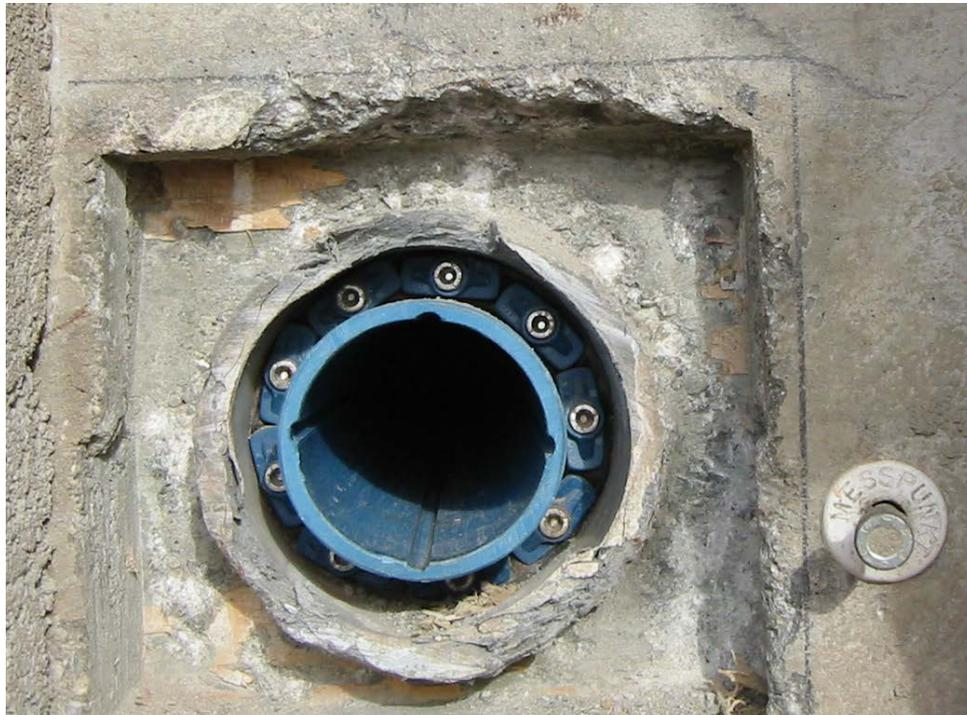
Foto 11: Durchführung des Messrohres durch das Widerlager, Fixierung des Rohres über Dichtungen (Gliederkette mit Kautschukdichtelementen, die über zwei Andruckplatten mit dem Futter- und Messrohr und verspannt wurden).
