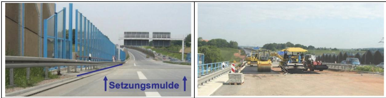
**Bild 1-2:** Setzungsmulde über Hinterfüllung an der BAB A72, Asphaltdeckschicht bereits abgefräst.
