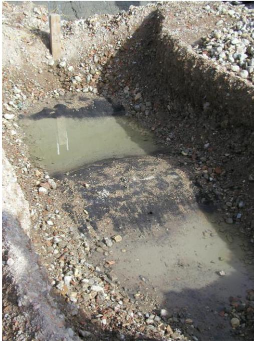
**Bild 1.2** Freigelegter Geokunststoff in einer Baustraße, nach mehrfachem Befahren
