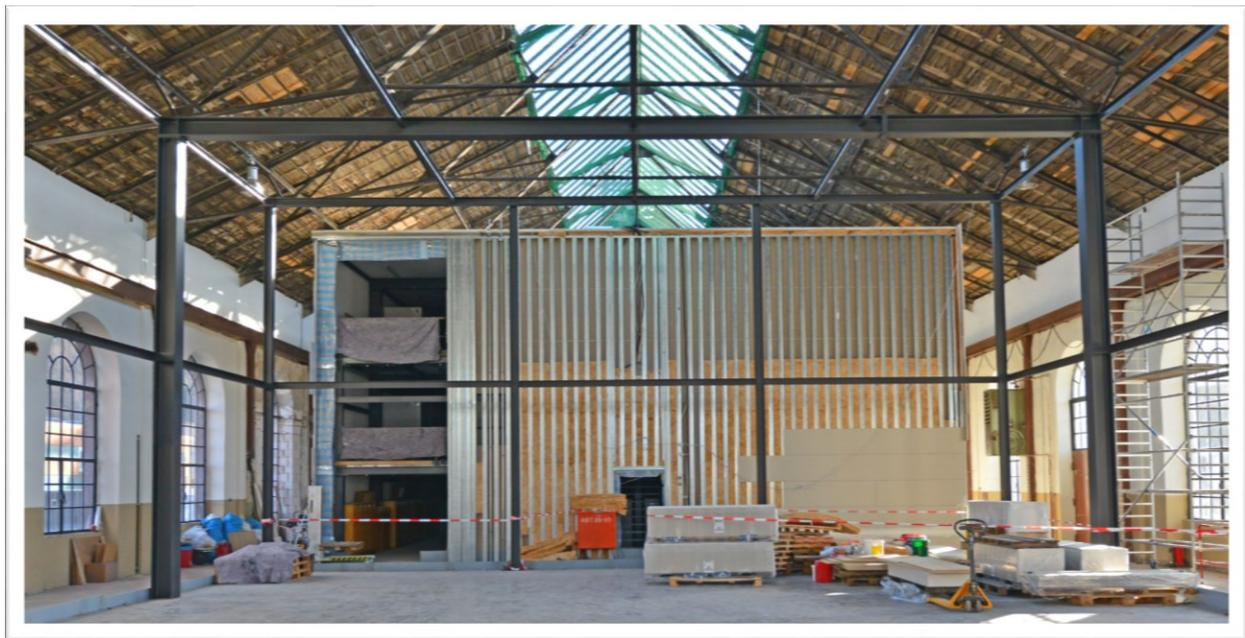
Abb. 2: Der Risswerk-Cubus in der Endphase des Aufbaus: man sieht in der hinteren Bildmitte den weitestgehend geschlossenen Cubus in der historischen Maschinenhalle. Durch die links noch zu erkennende, über drei Etagen reichende Öffnung in der Außenhaut wurde das Archivinventar in den Cubus eingebracht. [Bild: Axel Schäfer]
