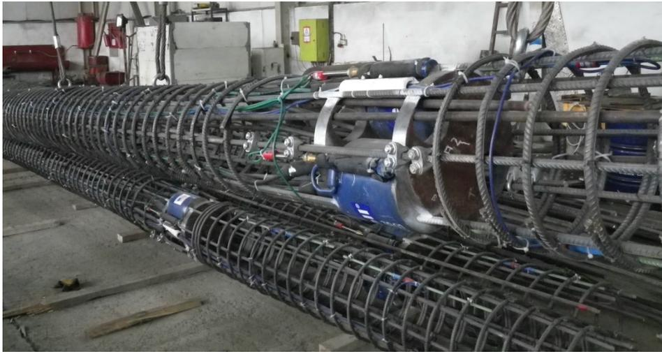
Abb. 3: Instrumentierte Bewehrungskörbe mit O-cell®
