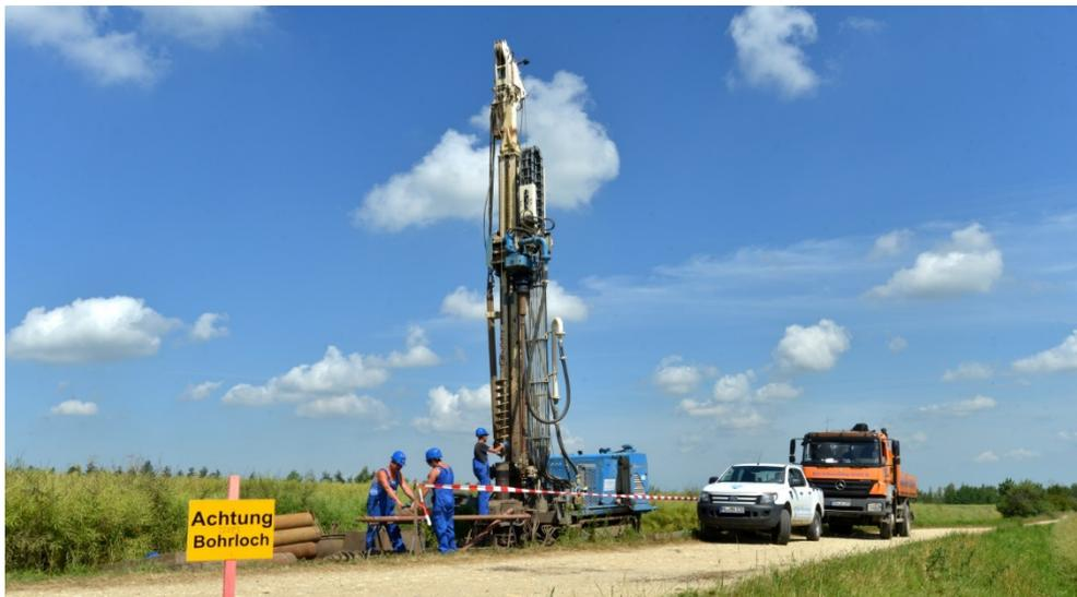
Abb. 6: Bohrgerät in der Vorfelderkundung (Quelle: Bohr und Brunnenbau GmbH 2018)
