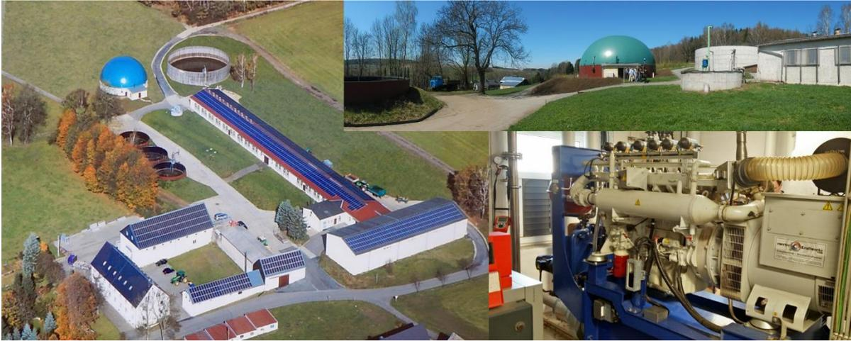
**Abbildung 4.19** – Biogasanlage der Agrargenossenschaft Clausnitz mit 75 kW(el) in der Gesamtansicht und einer Detailaufnahme des BHKW
