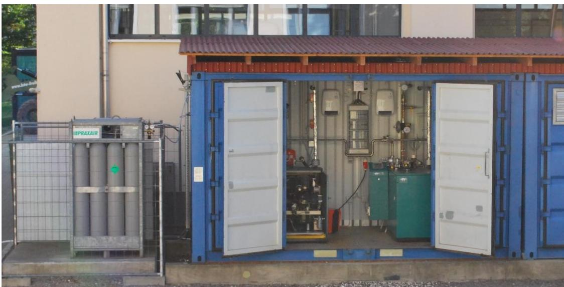
**Abbildung 4.4** – Unterbringung des Brennstoffvorrates, der Wärmesenke und der beiden BHKW in einem 15“-Container; das linke BHKW ist das Heizölaggregat ohne Schallisierung und das rechte BHKW ist der Versuchsträger für diese Arbeit
